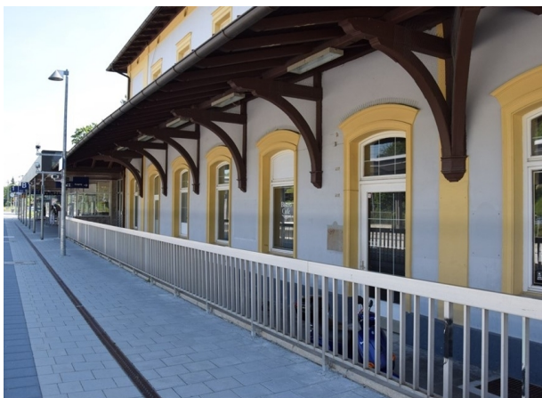
EG Tutzing Ansicht Bahnsteig
